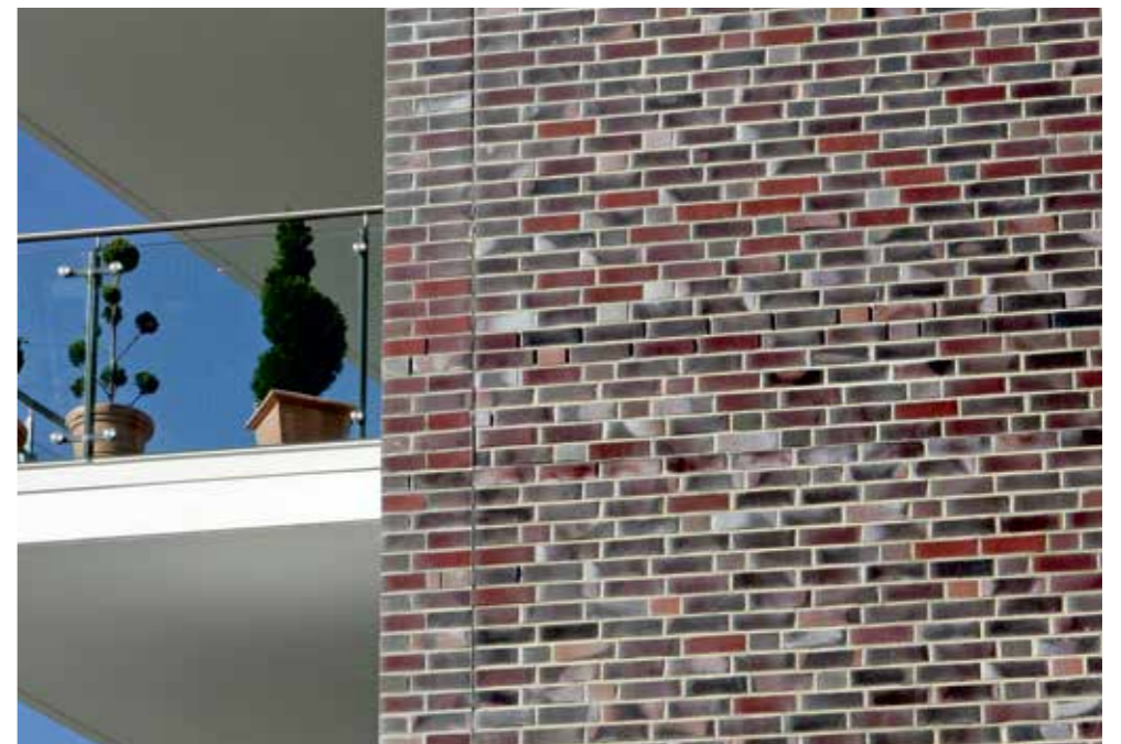
Zwei, die gut zusammenpassen: Der nuancenreiche Röben Klinker OXFORD, NF, und der Wilde Verband, der das Farbspiel dieses Steines aus tiefem Rot bis hin zu schillernden Anflammungen besonders gut unterstreicht.
