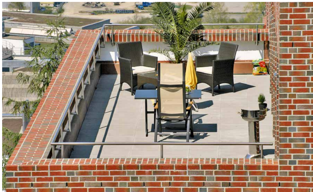
Die Brüstung dieser Dachterrasse wurde mit nach innen geneigten, schlagregendichten Fertigbauteilen abgedeckt.
