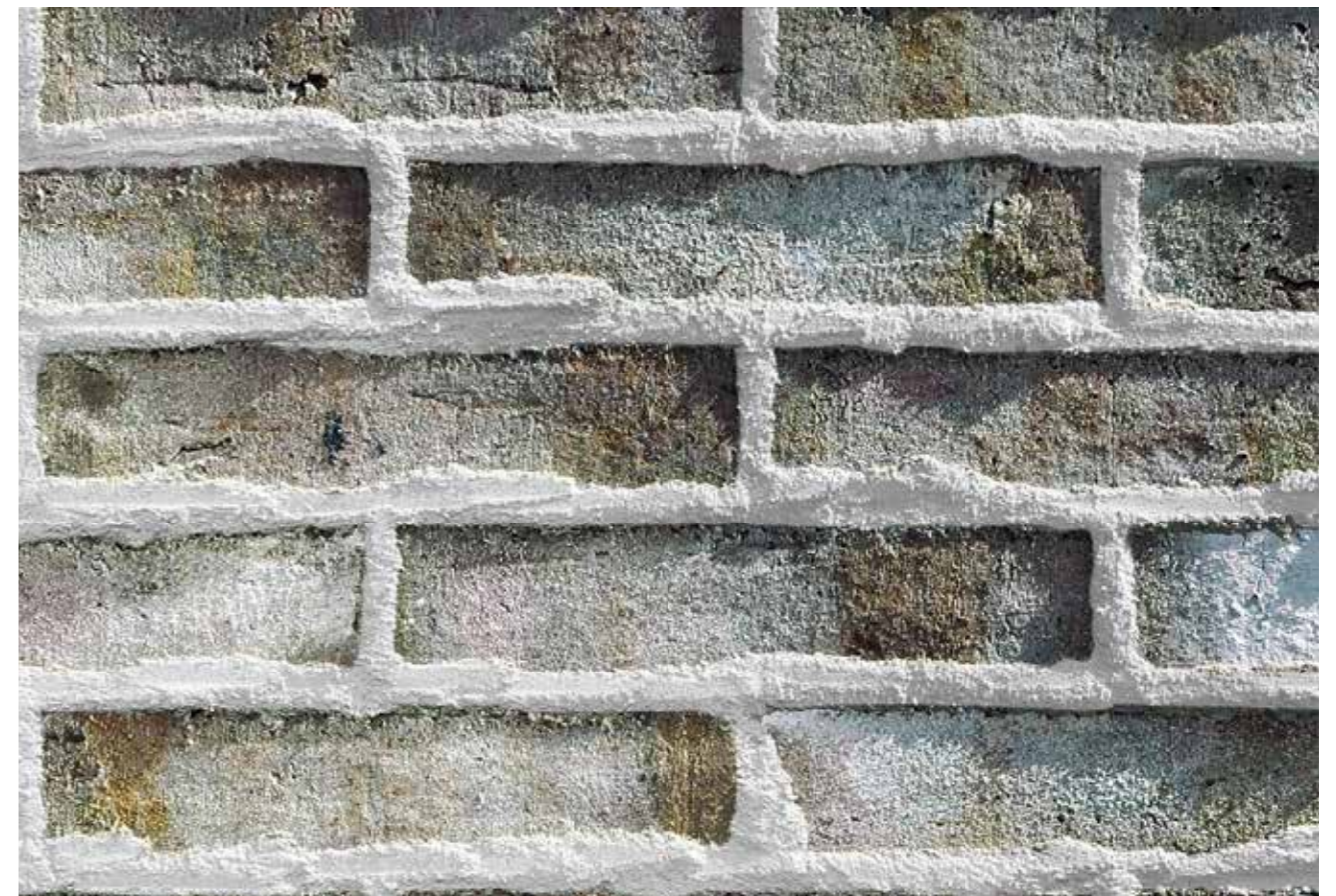
Passt nicht zu jedem Stein: Die vorspringende Fuge. Aber in diesem Fall mit dem urigen, kohle-weißen Handform-Verblender eine außergewöhnlich attraktive Variante.
