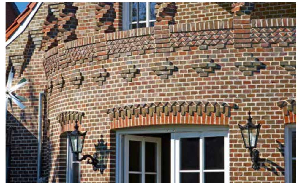
Kunstvoll ausgebildete Stürze mit Zierstreifen aus geschnittenen Steinen, reliefartig gestaltete Mauerpartien, spiralförmig versetzte Steine als säulenartige Mauerecken. Die Maurer haben hier ganze Arbeit geleistet. Röben Handfom-Verblender WASSERSTRICH buntgeflammt.
