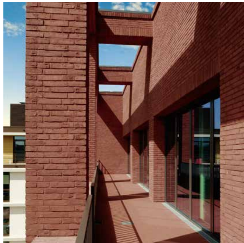
Der Rößen Handform-Verblender WIESMOOR mit rotem Fugenmörtel. So fügt sich der rustikale, rote Stein wie selbstverständlich in die strenge Architektur.
