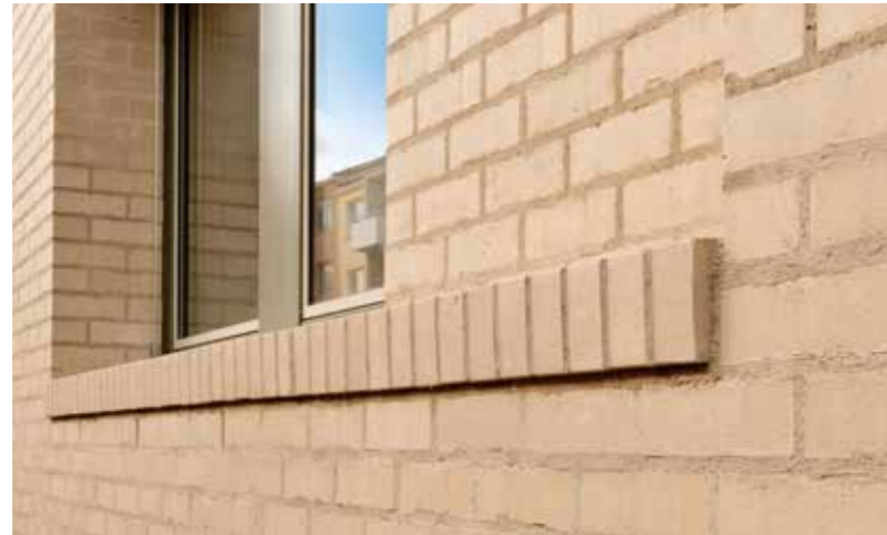
Bündig abgezogene, nicht zusätzlich verdichtete Mörtelfugen.
