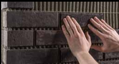
Укладка плоских клинкерных плиток с помощью шнура. Клинкерные плитки вдавливаются в слой клея.
