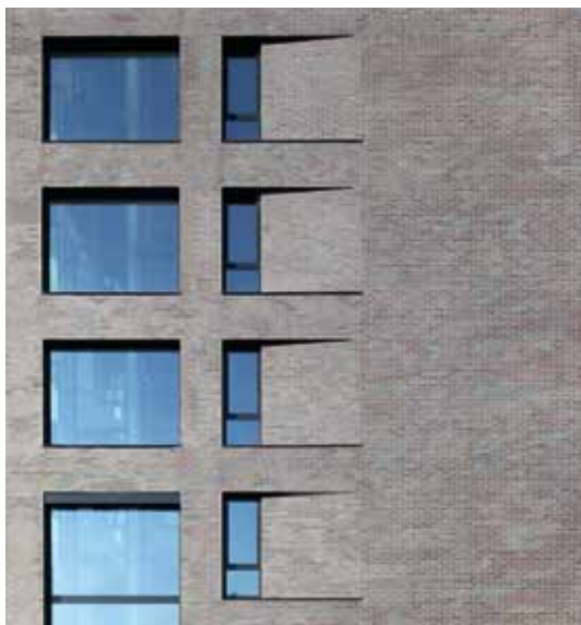
Кампус в Дорнбирне, Австрия Плитка фасадная 2110/336 metallic schwarz Плитка угловая 2640/336 metallic schwarz
