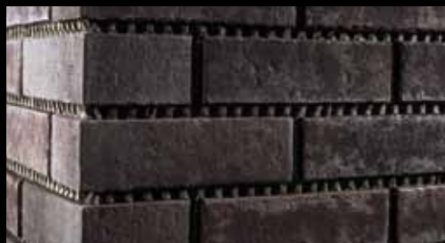
Полностью облицованная поверхность. После времени выдержки можно приступить к расшивке швов.
