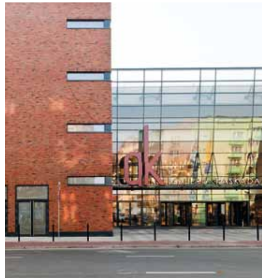
Торговый дом, Каскада Щецин, Польша Плитка фасадная 7440/353 eisenrost
