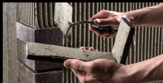
С уголками работают по методу двойного намазывания.
