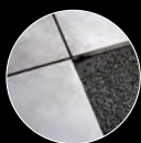
Свободная укладка на гравийную подушку.
